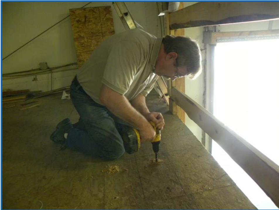
**WITH 5/8" BIT: DRILL STRAIGHT-DOWN AT 4 MARKED LOCATIONS**
