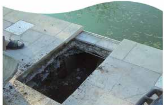
6 - Fin des gros travaux
