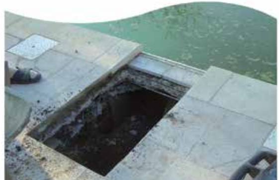
6 - Fin des gros travaux
