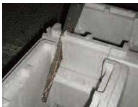
Découpe à la scie du bloc de départ de l'angle en haut et en bas (passage du béton + fers). Répéter cette découpe à chaque angle et pour tous les niveaux.
