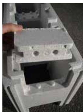
Bouchon haut avant mise en place
