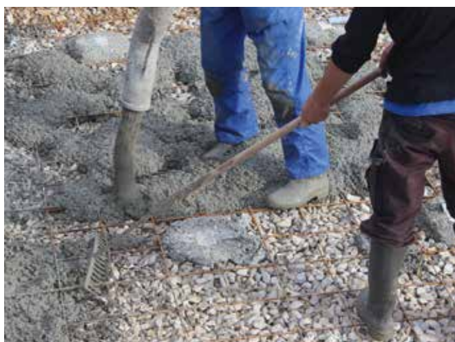
Coulage fond plat
