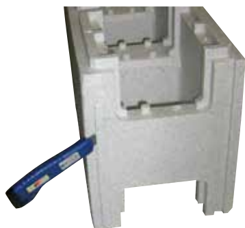
Découpe au cutter de la languette mâle du bloc qui sera en butée dans l'angle
