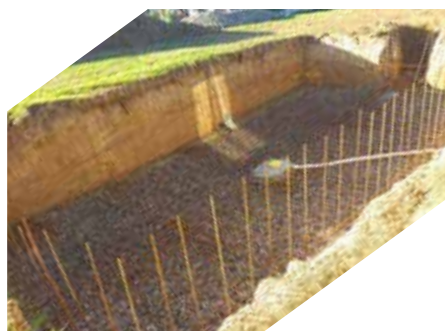
Treillis avec attentes verticales
