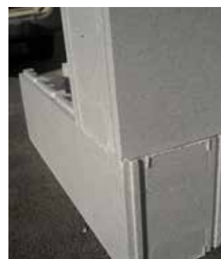
Détail d'angle avec bouchons assemblés
