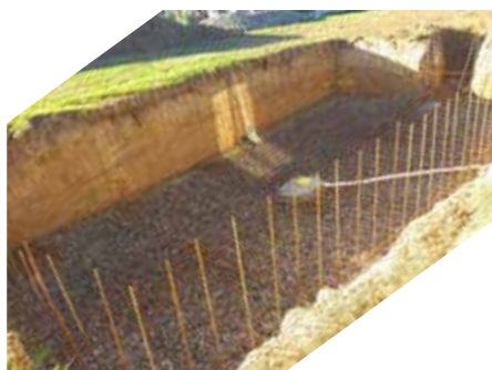
Treillis avec attentes verticales
