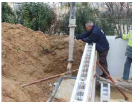
Attention à amorcer la pompe en dehors de la structure
