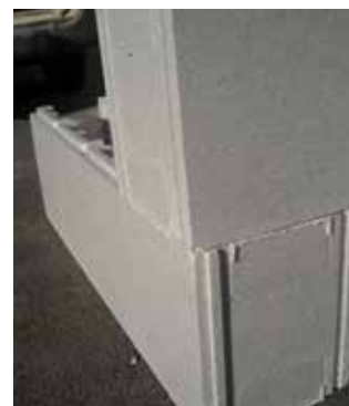
Détail d'angle avec bouchons assemblés
