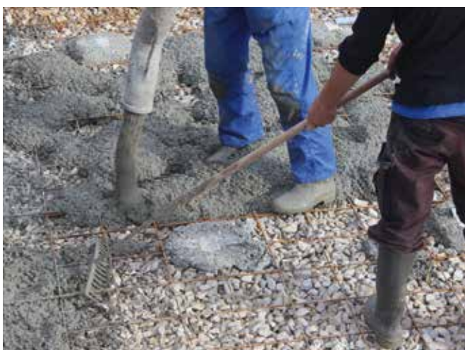
Coulage fond plat
