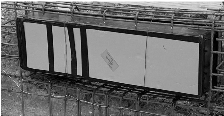
Image 4 BADUJET Turbo Pro - Jet placement in rebar
